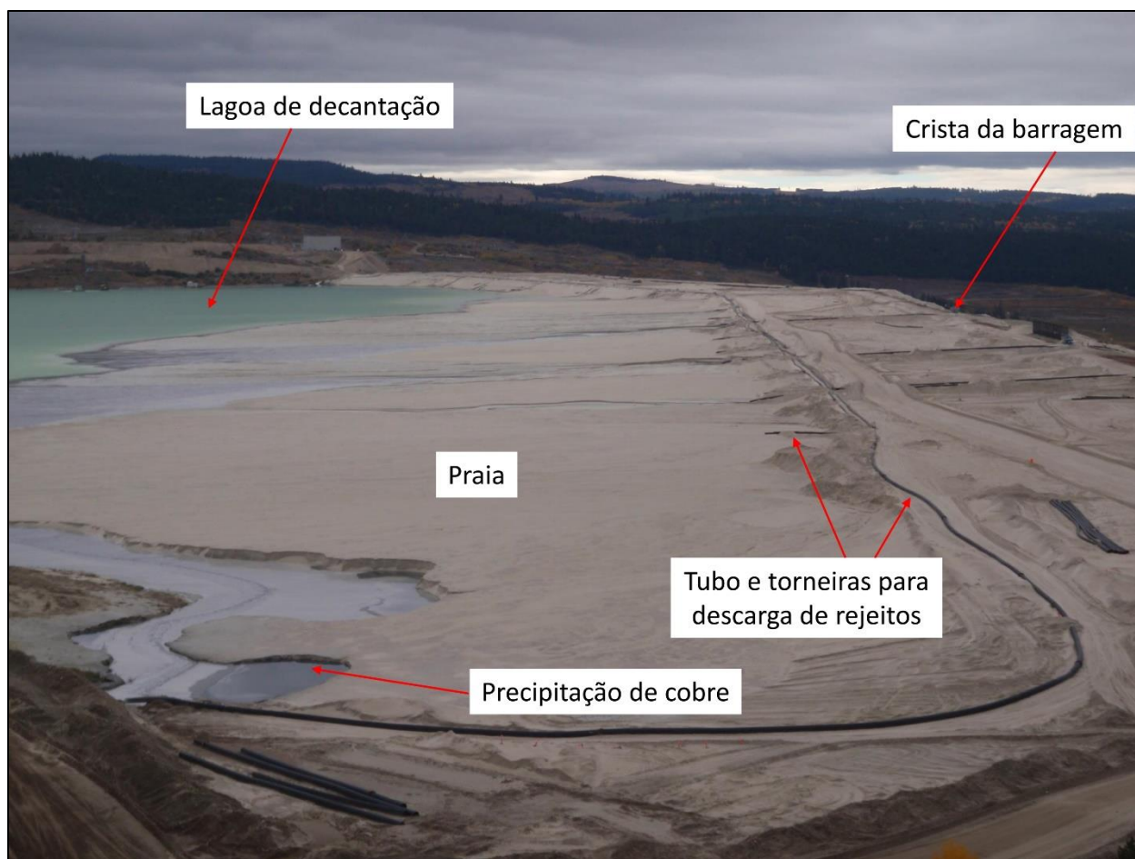
Figura 5. Na instalação de armazenamento de rejeitos da mina Highland Valley Copper, na Colúmbia Britânica, os rejeitos úmidos são descarregados na direção a montante de um tubo e torneiras ao longo da crista da barragem. Partículas maiores (areias) são depositadas perto da barragem para formar uma praia. Partículas menores (limos) são transportadas para mais longe da barragem para formar uma lagoa de decantação. A precipitação de cobre no reservatório de rejeitos indica a extração incompleta de cobre do minério. Foto tirada pelo autor em 27 de setembro de 2018.
